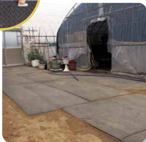
ビニールハウスアプローチ養生
